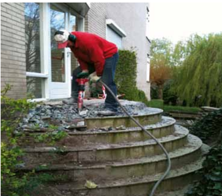
De bestaande vluchttrap is verouderd en wordt gesloopt.
