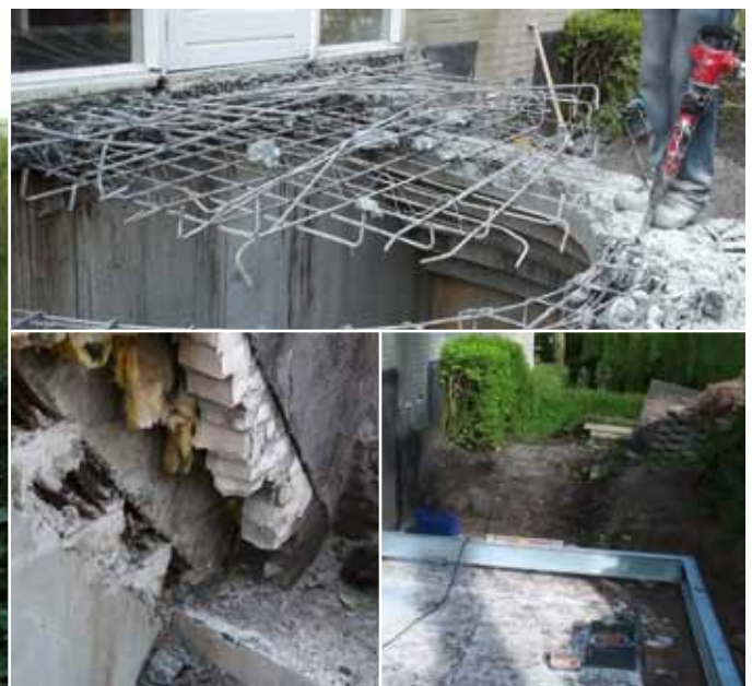
Na het slopen van de bovenste vloer en trede bleek de bestaande onderliggende wapening niet in gebruik en netjes weggebogen in een stekkenbak.
