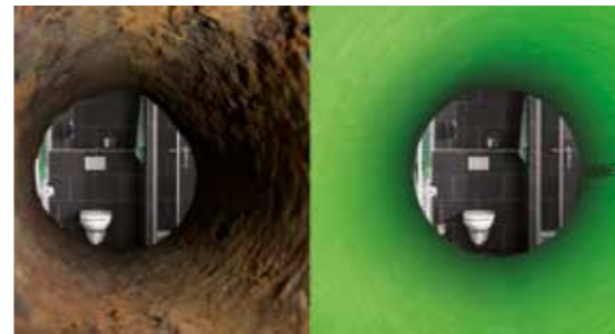
(links) Standleiding oud (rechts) Standleiding nieuw
