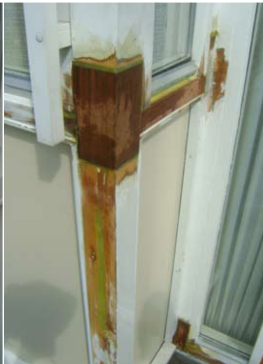
De situatie na uitvoeren reparaties, voordat het geschilderd is.
